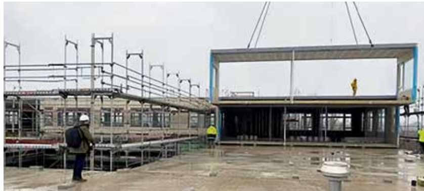
Jedes der 37 Module wiegt bis zu 23 Tonnen
